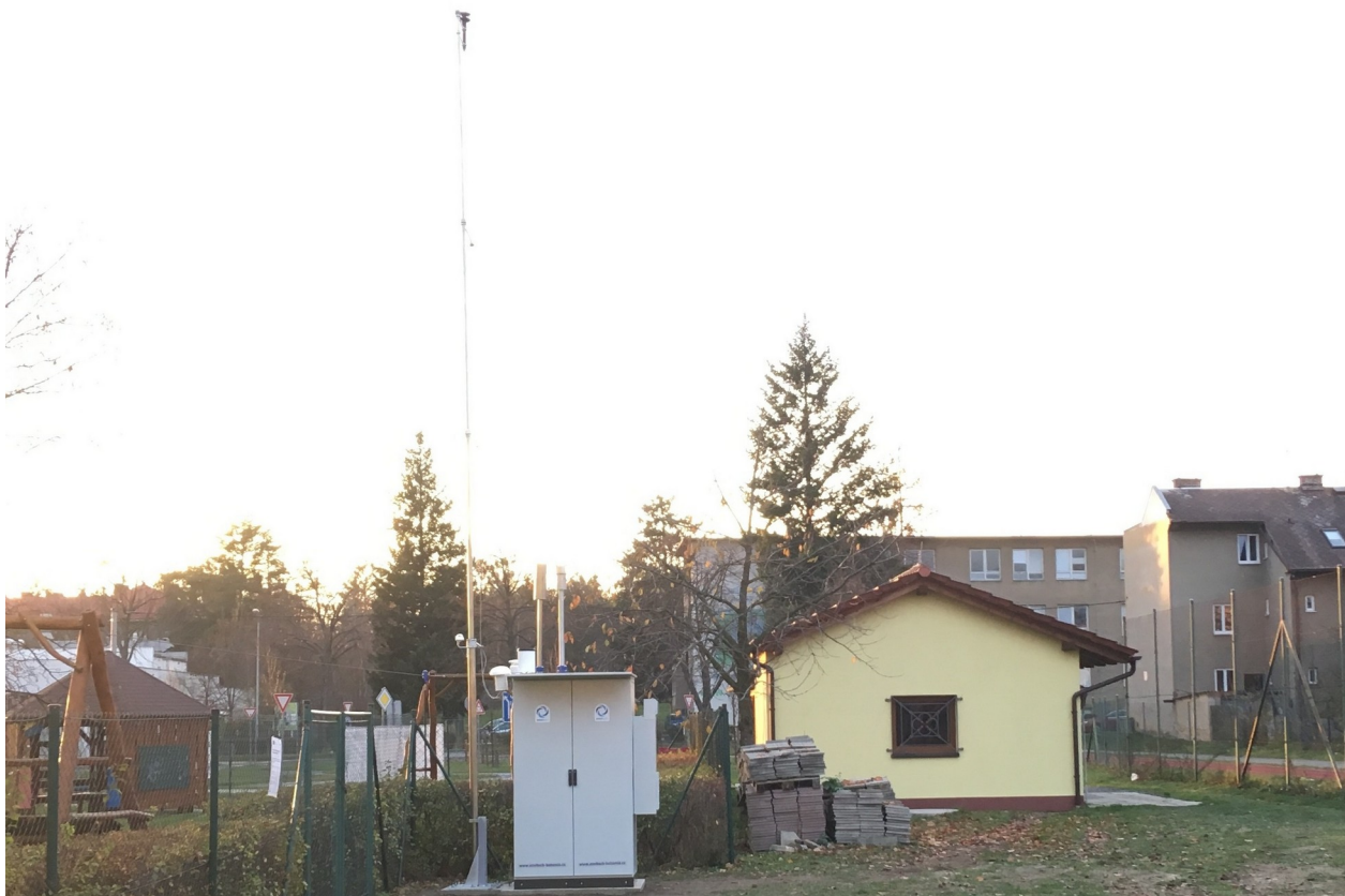
Obr. 1: Měřicí stanice kvality ovzduší v lokalitě Hranice
